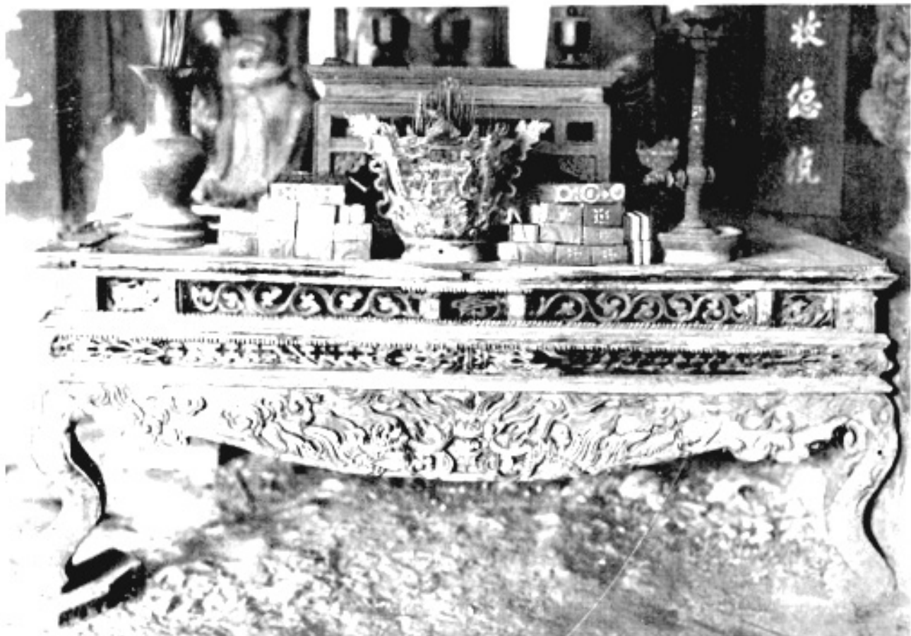
Planche LXX. — Le meuble de Son-Tày, vu de face, tel qu'il était avant sa restauration.
